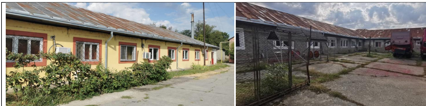
Figura 6 Clădirea administrativă C1 a DPB
